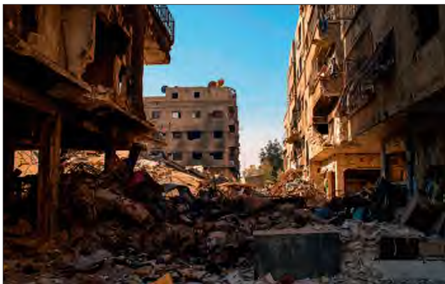
Разрушенный боевиками ИГИЛ Дамаск.
